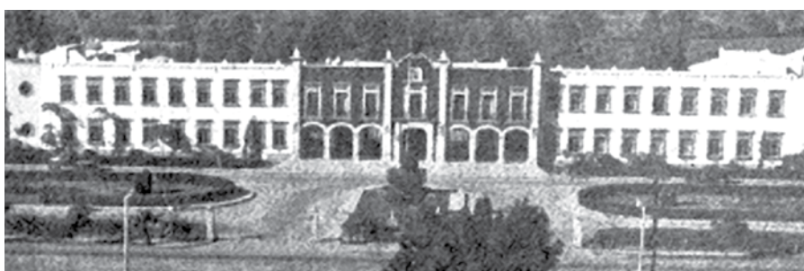
Edificio Principal de Rectoría, 1948.
